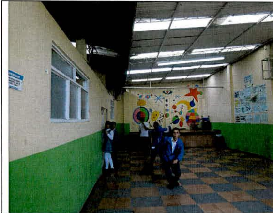
Fotografía 3. Vista interior de la edificación evaluada.
