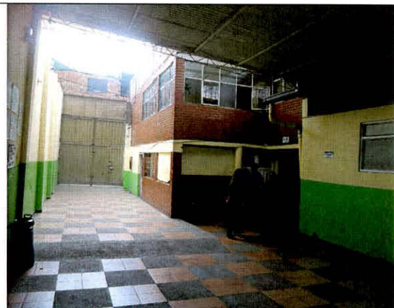
Fotografía 4. Vista interior del techo la edificación evaluada.
