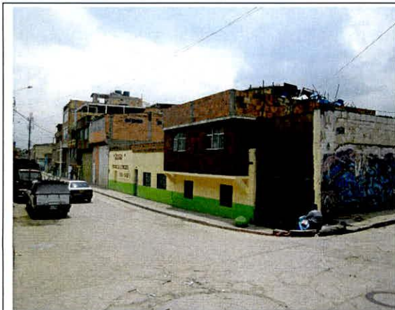
Fotografía 1. Vista de la fachada de la edificación emplazada en el predio de la referencia.
