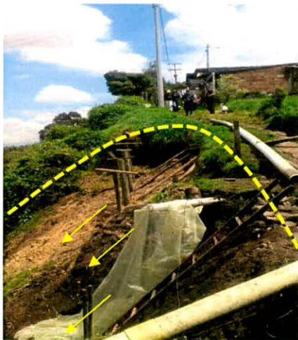
Fotografías 10 y 11. Vista de la parte alta del proceso de remoción en masa donde se afecta el sendero peatonal que da acceso a las viviendas donde habitan el señor Oscar Galán y la señora Dora Castañeda con sus familias. Se observa la reinstalación de una tubería de aguas residuales por parte de la comunidad. emoción en masa locales (Fotografía tomada el 15 de Mayo)
