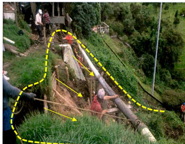
Fotografías 10 y 11. Vista de la parte alta del proceso de remoción en masa donde se afecta el sendero peatonal que da acceso a las viviendas donde habitan el señor Oscar Galán y la señora Dora Castañeda con sus familias. Se observa la reinstalación de una tubería de aguas residuales por parte de la comunidad. emoción en masa locales (Fotografía tomada el 15 de Mayo)
