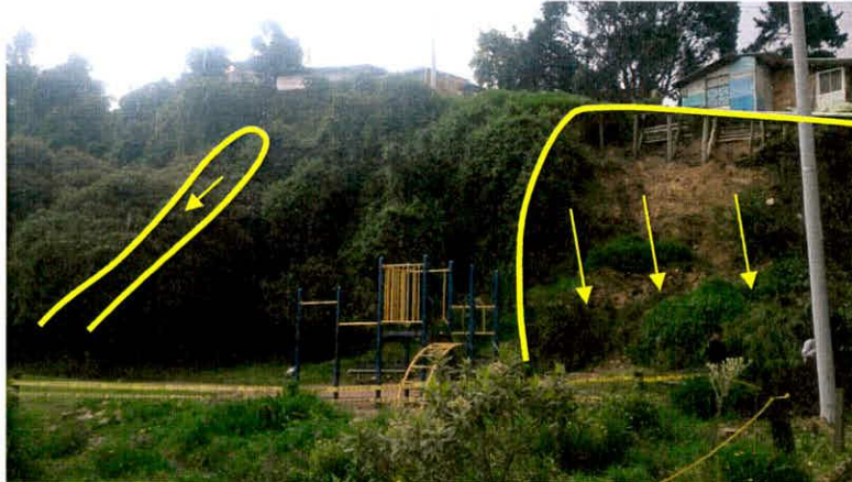
Fotografía 9. Vista del talud del costado norte del Parque Distrital Mirador de los Nevados, en donde se identifican los procesos de remoción en masa locales (Fotografía tomada el 15 de Mayo)
