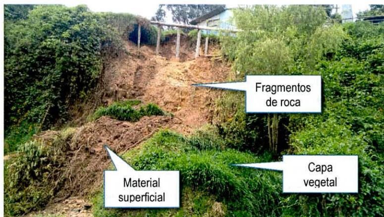
Fotografía 4. Características generales del talud. (Fotografía tomada el 19 de Abril)
