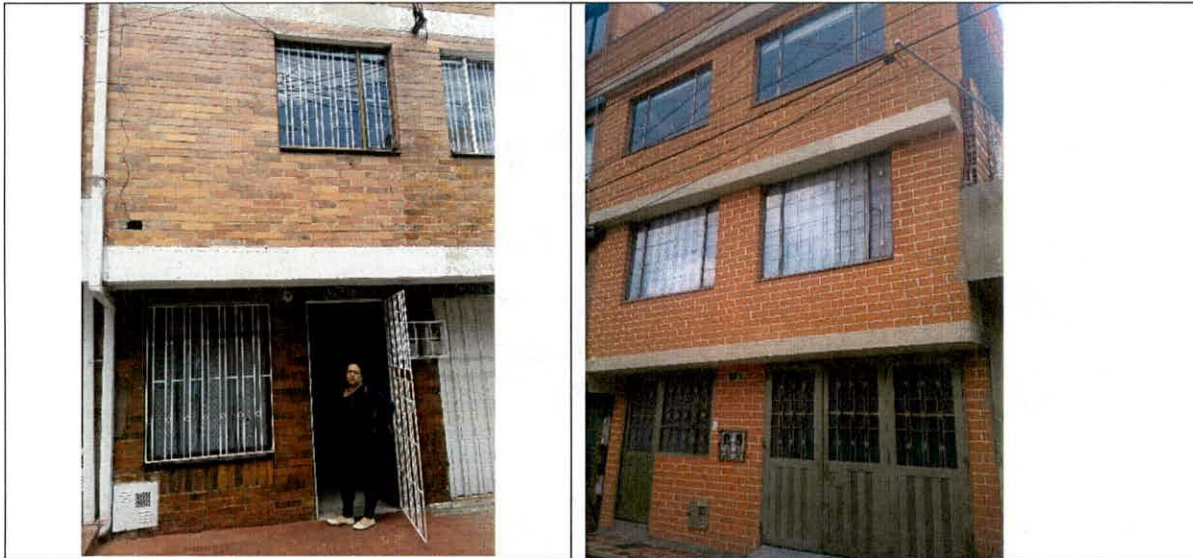
Fotografía 3,4: Vista de las fachas de las viviendas evaluadas en el sector de la Calle 159 A y Calle 160 entre Carrera 7 y Carrera 7 G, en el barrio Barracas Norte de la Localidad de Usaquén
