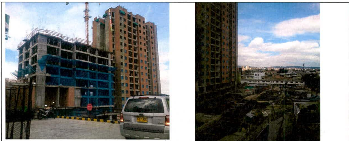
Fotografía 13,14: Construcción aladaña en el predio de la Carrera 7 N° 158-51, ubicada al costado sur de las viviendas evaluadas en el sector de la Calle 159 A y Calle 160 entre Carrera 7 y Carrera 7 G, en el barrio Barracas Norte de la Localidad de Usaquén
