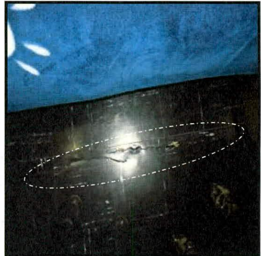
Fotografías 4 y 5. Fisura de tendencia longitudinal sobre el acabado del entrepiso del predio de la Diagonal 5A No 72D-15.
