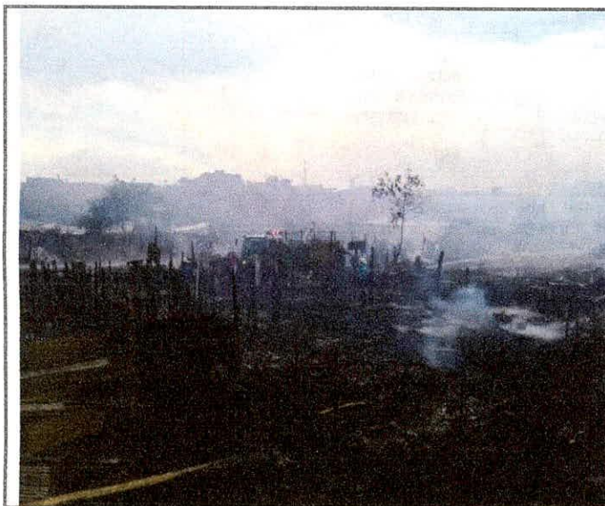
Fotografía 1. Zona ubicada entre la Calle 144 y el río Bogotá y entre la Carrera 151 A y la Carrera 151 G. Se observa la zona afectada por el incendio ocurrido el día 24 de Abril de 2017.
