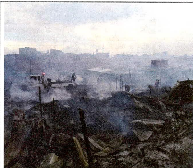
Fotografía 2. Zona ubicada entre la Calle 144 y el río Bogotá y entre la Carrera 151 A y la Carrera 151 G. Se observa la zona afectada por el incendio ocurrido el día 24 de Abril de 2017.
