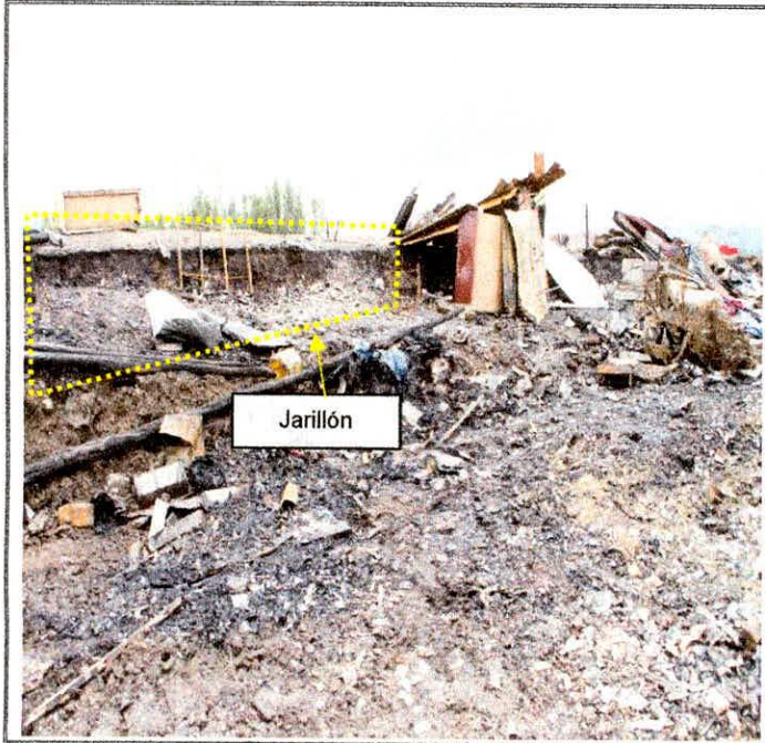
Fotografía 7. Excavaciones desarrolladas sobre el costado sur del jarillón del río Bogotá en la zona denominada Gavilanes entre la Calle 144 y el río Bogotá y entre la Carrera 151 A y la Carrera 151 G.
