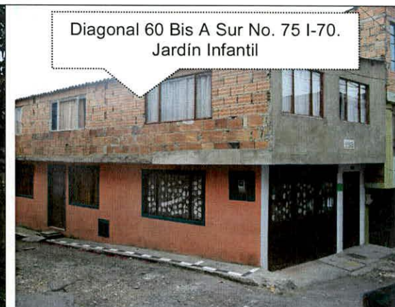
Fotografía 4. Vista de la edificación ubicada ladera abajo del talud de corte evaluado donde se ubica jardín infantil.
