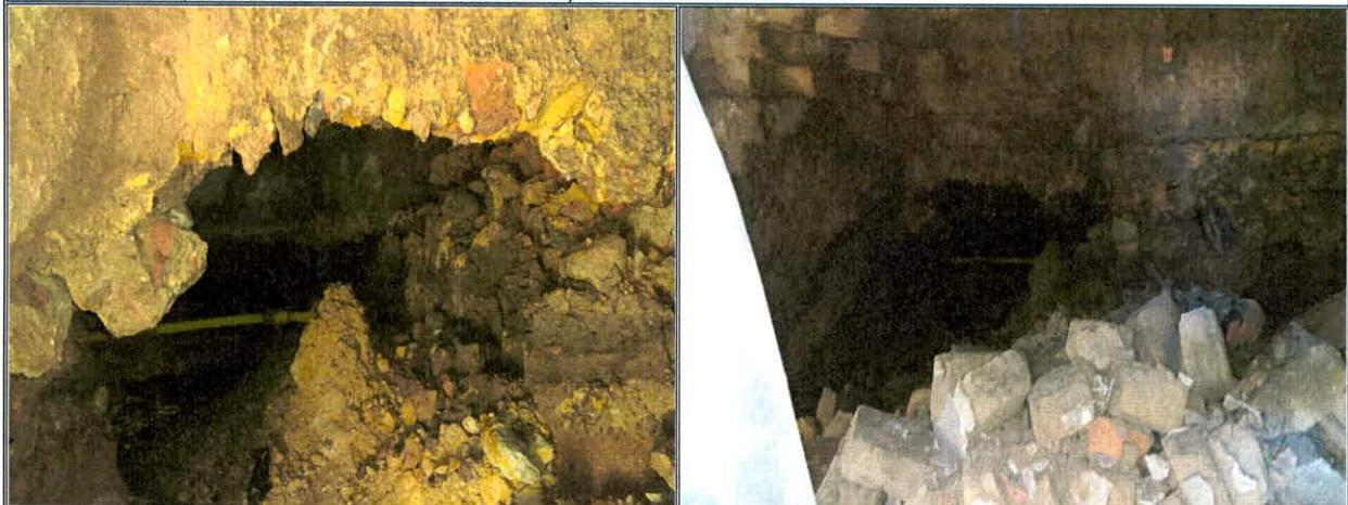
Fotografías No. 3 y 4. Rotura de una red tubería de agua potable, generando la pérdida de material de soporte del muro de cerramiento de este costado y posteriormente el colapso de un 20% del mismo. (Foto tomada 22 de enero de 2017).
