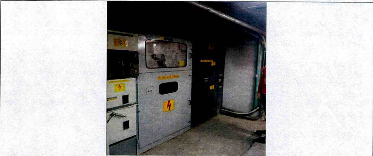
Fotografía 2: Área de la subestación eléctrica, donde se ubican las cajas de alta tensión.
