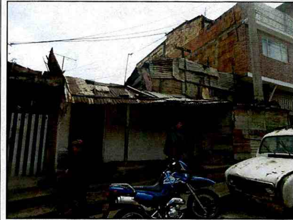
Foto 1. Vista de la vivienda emplazada en el predio de la Calle 48 Sur No. 1D-10 Este, Barrio Canadá Güira II Sector de la Localidad de San Cristóbal.
