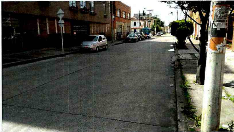
Fotografía 2. Vista general de la Carrera 18 entre Calle 33A y Calle 34, no se presenta deterioro.
