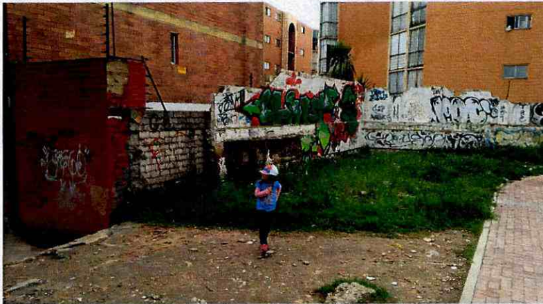
Fotografía 1. Vista general del muro de cerramiento del costado oriental del predio de la Carrera 95A # 136 - 42.
