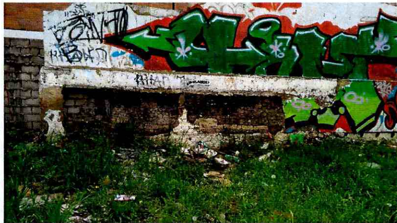
Fotografía 3. Estructura del muro columnas y viga de concreto a media altura
