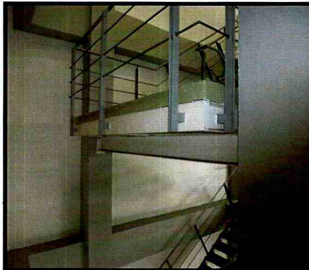
Fotografía 1. Estructuras de escaleras y pasillos adosados a la estructura principal de la edificación del predio de la Avenida Calle 26 No 103-08 Entrada 1 Interior 8
