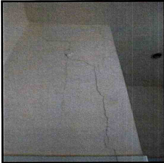
Fotografías 6 y 7. Fisura de en los muros divisorios de la edificación evaluada
