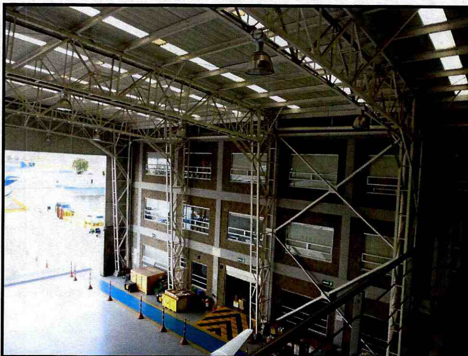
Fotografía 3. Espacio destinado para el parqueo de aeronaves de tamaño pequeño junto a la edificación evaluada
