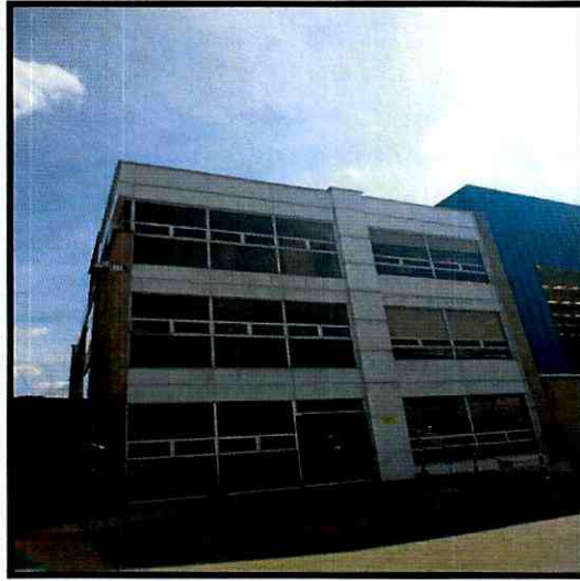
Fotografía 1. Vista desde el exterior de la edificación del predio de la Avenida Calle 26 No 103-08 Entrada 1 Interior 8.
