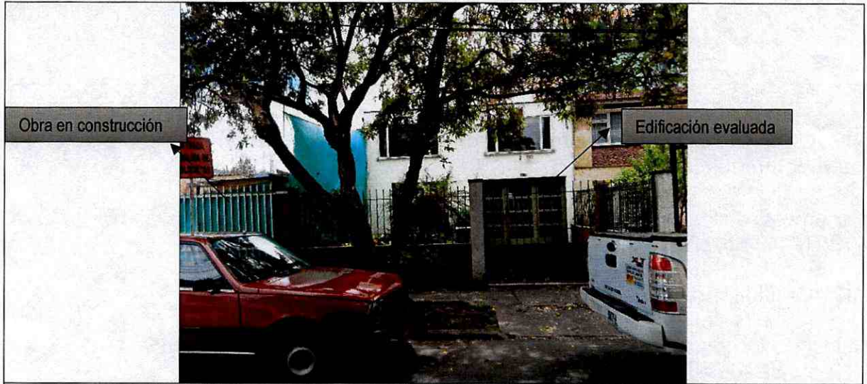
Fotografía 1: Vista de la vivienda evaluada en el predio de la Calle 99 N° 49-65, en la Localidad de Barrios Unidos.
