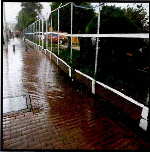
Fotografías 4 y 5. Hundimientos de agrietamientos en los senderos peatonales perimetrales a la sede principal de Colegio Elisa Borrero de Pastrana.
