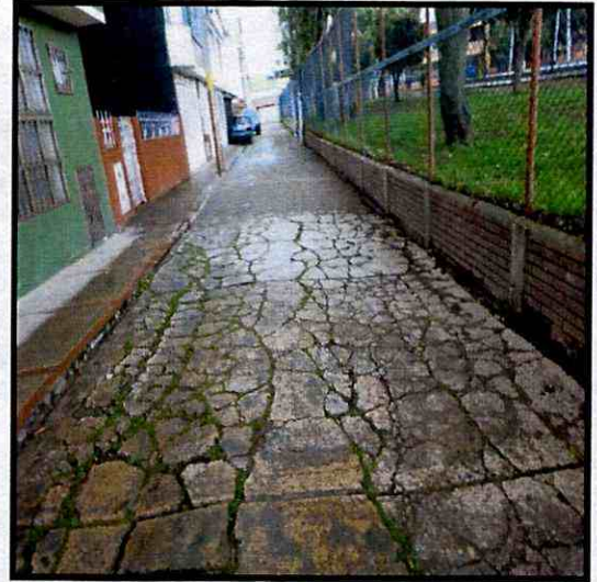
Fotografías 4 y 5. Hundimientos de agrietamientos en los senderos peatonales perimetrales a la sede principal de Colegio Elisa Borrero de Pastrana.
