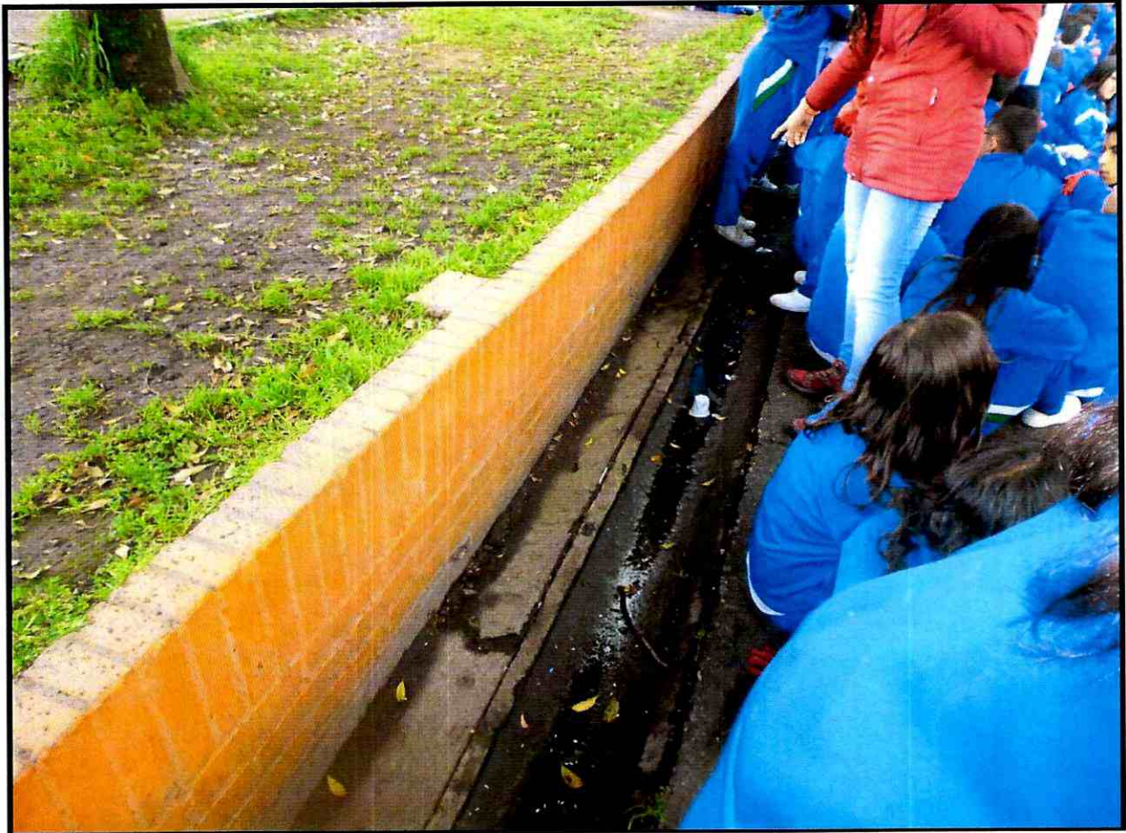
Fotografías 7. Muro de contención del terreno sobre el cual se encuentra la cancha de microfútbol del costado norte
