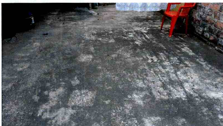
Fotografía 3. Estado actual de la placa de terraza, no se evidencian fisuras o grietas
