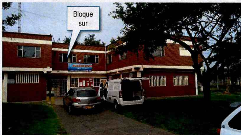
Fotografía 1. Vista general del bloque sur del Salón comunal ubicado en la Transversal 71 Bis # 75A – 48.
