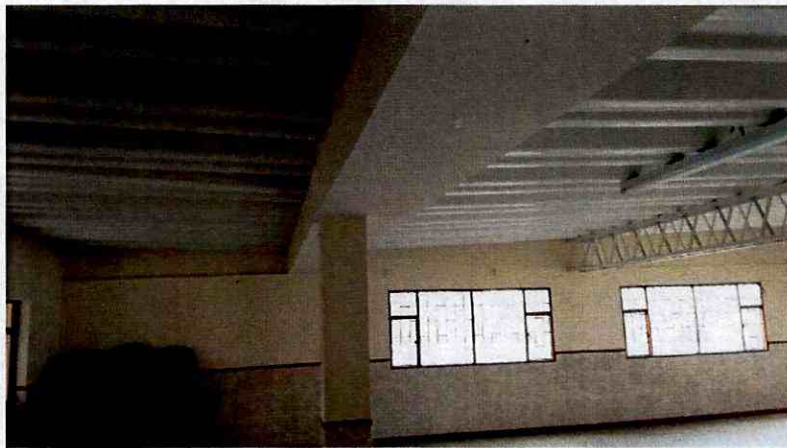
Fotografía 5. Cubierta y estructura en buen estado del bloque sur
