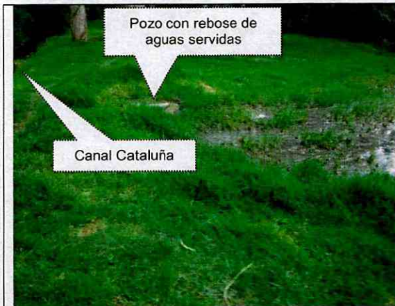
Fotografía 3. Vista de zona por encima del escarpe superior del movimiento, se identifica pozo de aguas servidas con rebose de aguas servidas. Fotografía tomada el 11 de Abril.
