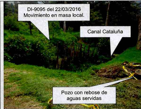
Fotografía 4. Vista de zona por encima del escarpe superior del movimiento, se identifica punto de remoción en masa de carácter local, descrito en DI-9035. Fotografía tomada el 11 de Abril.
