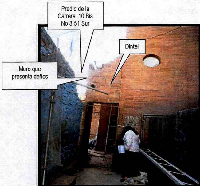
Fotografía 4. Entrada al área en donde se encuentra la construcción detenida.
