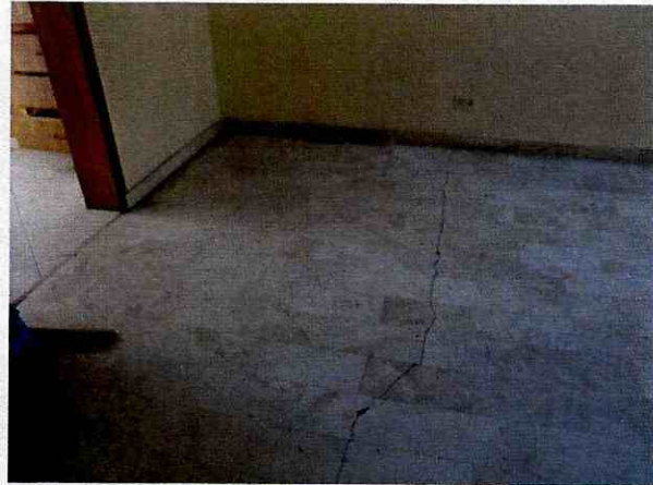
Foto 6. Vista de piso con presencia de fisura en zona de sala. 05 Septiembre de 2016.
