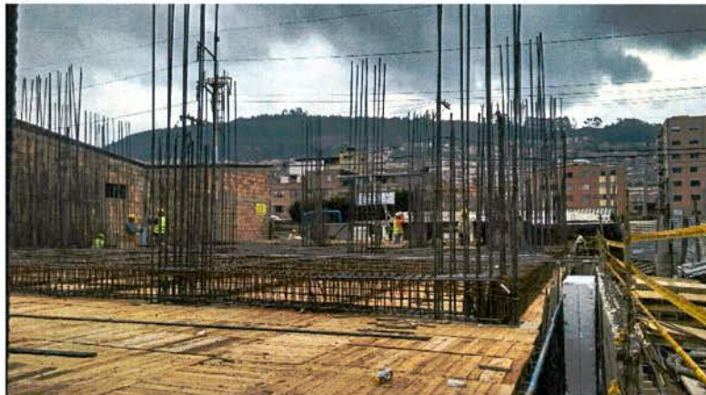
Fotografía 2. Obra que se adelanta en el predio de la Av. Carrera 9 # 185 A – 13.
