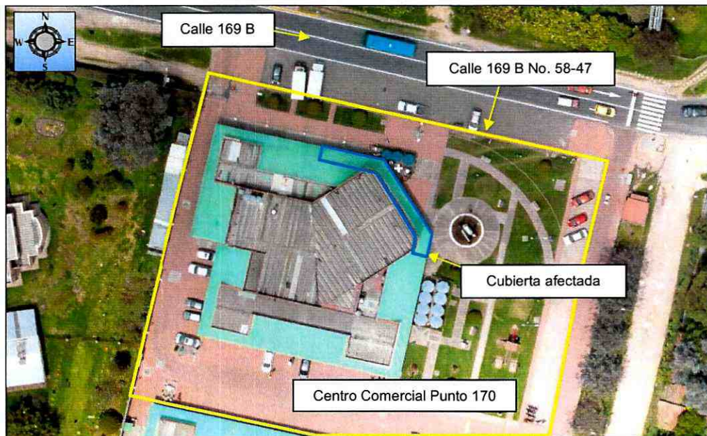
Figura 1. Aerofotografía del sector donde se ubica el Centro Comercial Punto 170, en el predio de la Calle 169 B No. 58 – 47, en el Sector Catastral Portales del Norte de la Localidad Suba.
