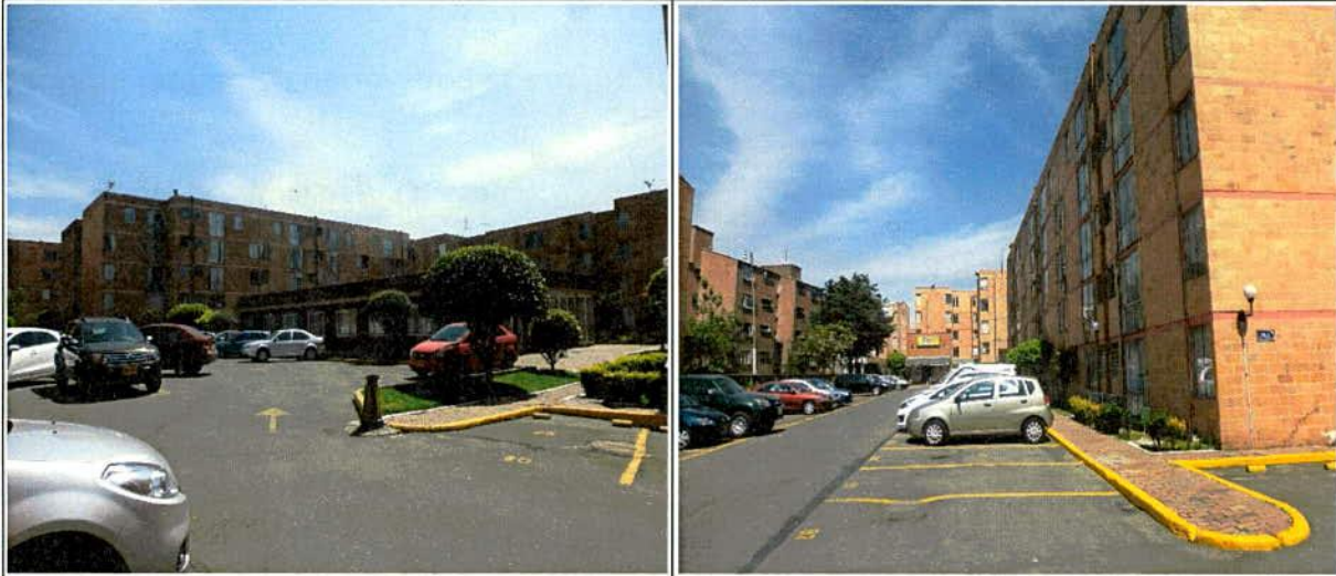
Fotografía 1y 2. Predio evaluado Calle 6D No 79A-76, Conjunto residencial Bosques de Castilla.
