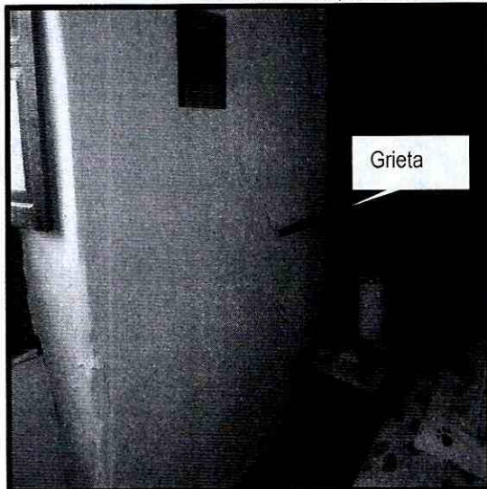
Fotografía 3. Fisuras en la cara externa del muro de cerramiento del costado sur, de la vivienda emplazada en el pedio de la Calle 9 Bis No 4-01 Este
