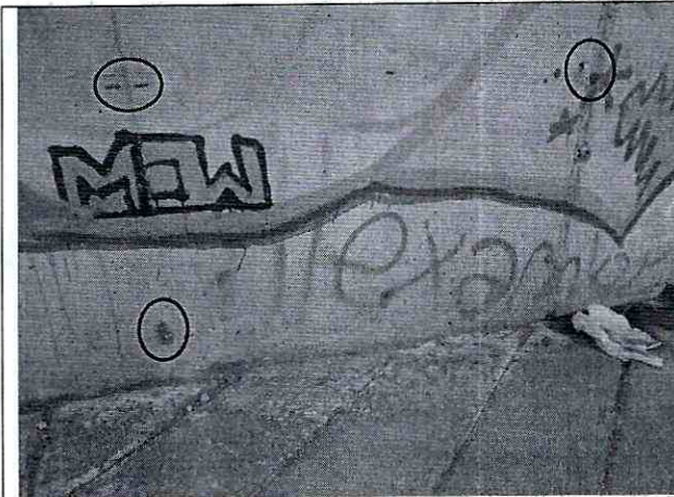
Fotografía 3: Vista de las corbatas de la formaleta dejada durante obra
