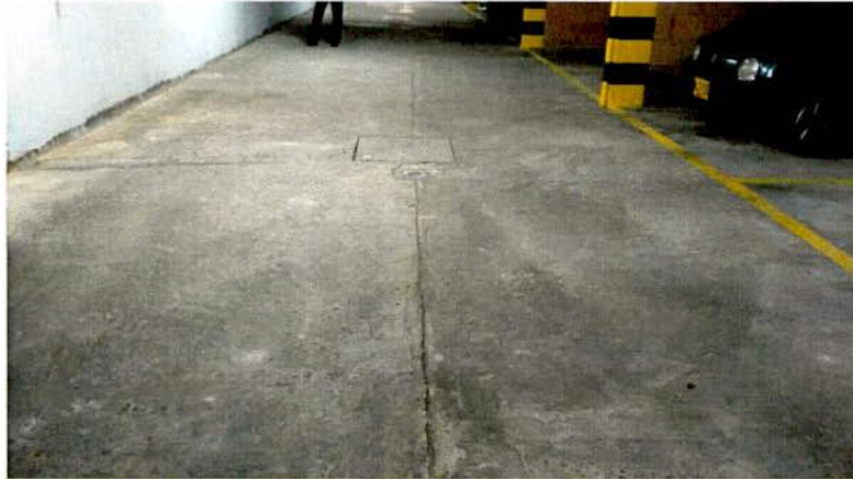
Fotografía 5. Placa de contrapiso de sótano en buen estado
