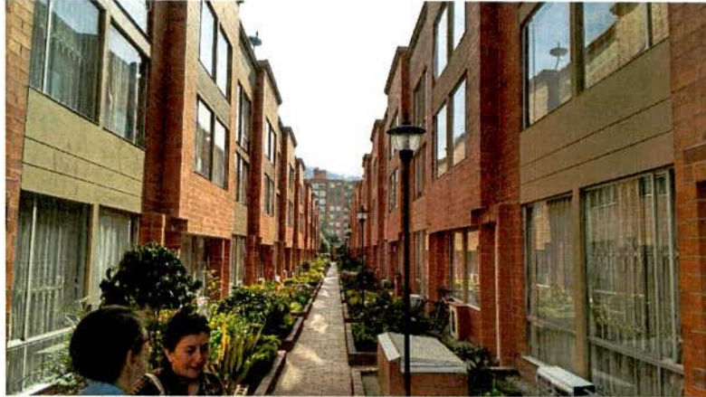
Fotografía 2. Aspecto general al interior de las viviendas del Conjunto Residencial ubicado en la Calle 174 # 8 – 90.
