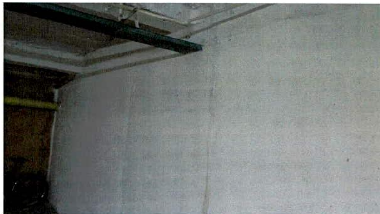
Fotografía 4. Muro de contención en buenas condiciones que presenta mantenimiento reciente.
