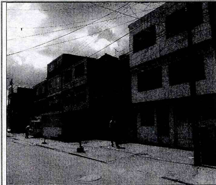
Fotografía 1. Vista de las viviendas evaluadas y ubicadas en los predios de la Carrera 81 No. 75 - 19 / 35 / 43 / 49 / 55 / 61, en el Sector Catastral La Soledad Norte de la Localidad de Engativá.
