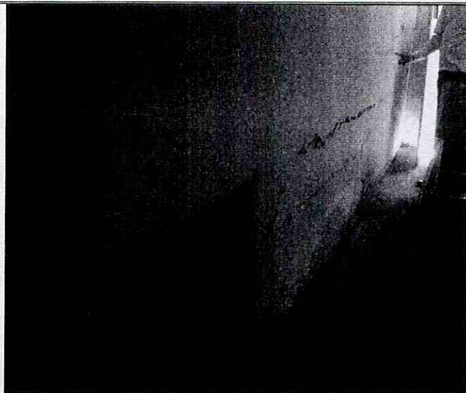
Fotografía 19. Grietas identificadas en muros de cerramiento de la ampliación de la zona posterior de la vivienda emplazada en el predio de la Carrera 81 No. 75 – 43, en el Sector Catastral La Soledad Norte de la Localidad de Engativá.
