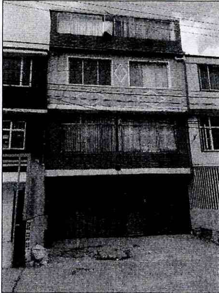
Fotografía 17. Vivienda ubicada en el predio de la Carrera 81 No. 75 – 43, en el Sector Catastral La Soledad Norte de la Localidad de Engativá.
