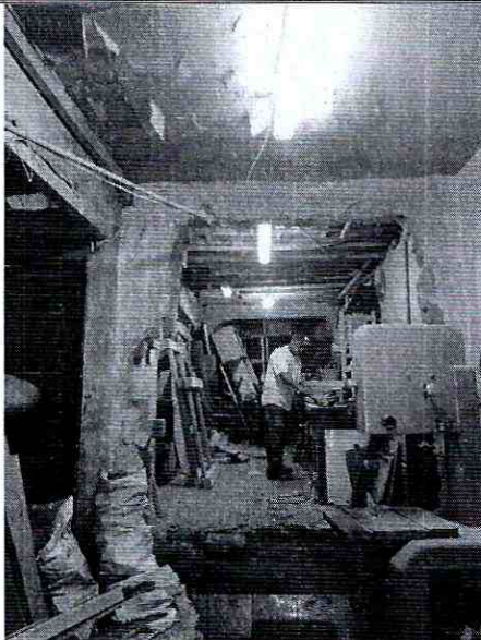
Fotografía 5. Vista al interior del primer nivel de la edificación
