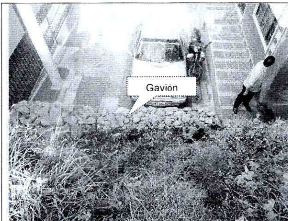
Fotografía 3. Vista por encima del talud de corte, sobre la Calle 156 A, donde se observa muro por gravedad (Gavión).
