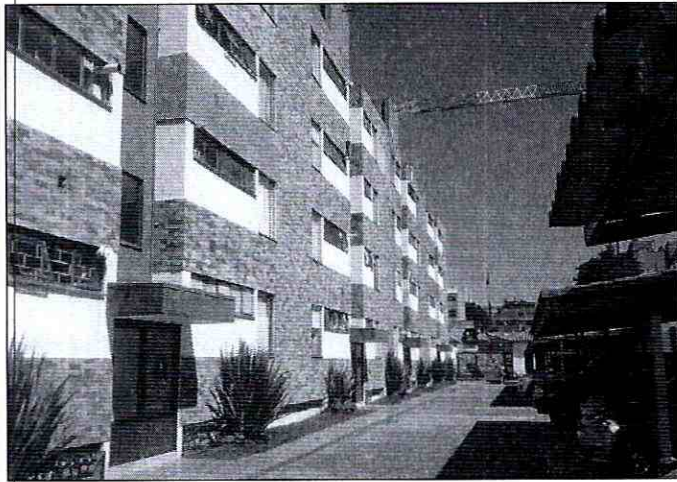
Fotografía 1. Vista de la edificación y de la zona de estacionamiento de vehículos del predio de la Calle 147 No. 11 – 27, en el Sector catastral Caobos Salazar de la Localidad Usaquén.
