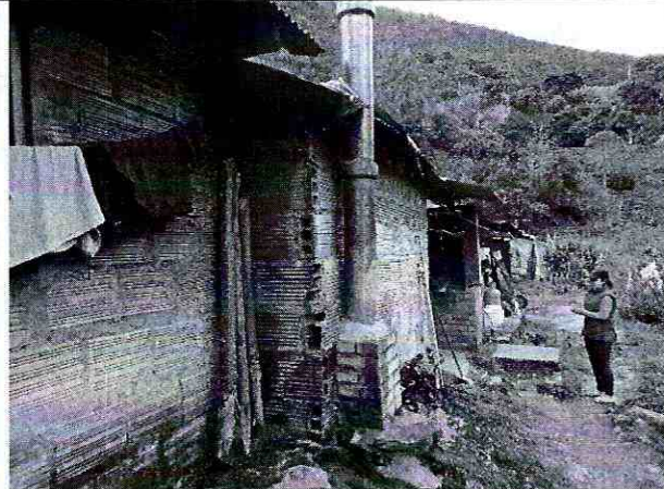
Fotografía 6. Vivienda construida en mampostería simple
