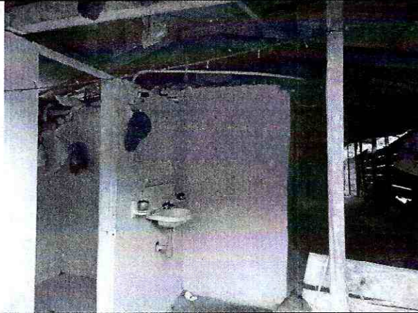
Fotografía 3. Vista de la parte posterior de la vivienda
