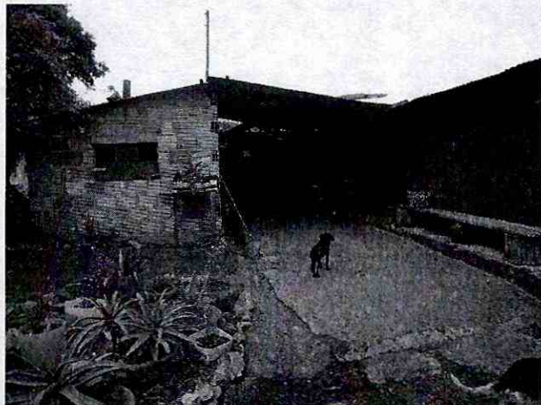
Fotografía 21. Vista del exterior de la vivienda de la Sr. Manuel Ramírez
