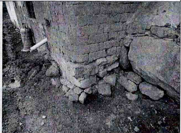
Fotografía 12. Vista de la cimentación de la vivienda
