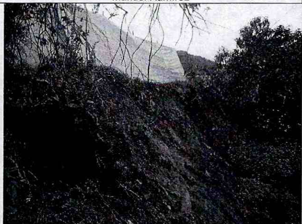
Fotografía 23. Deslizamiento observado hacia un costado del predio
