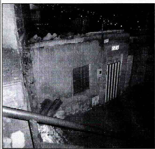
Foto 1. Vista de la vivienda emplazada en el predio de la Carrera 4K No. 52A-92 Sur, Desarrollo La Paz de la Localidad de Rafael Uribe Uribe.
