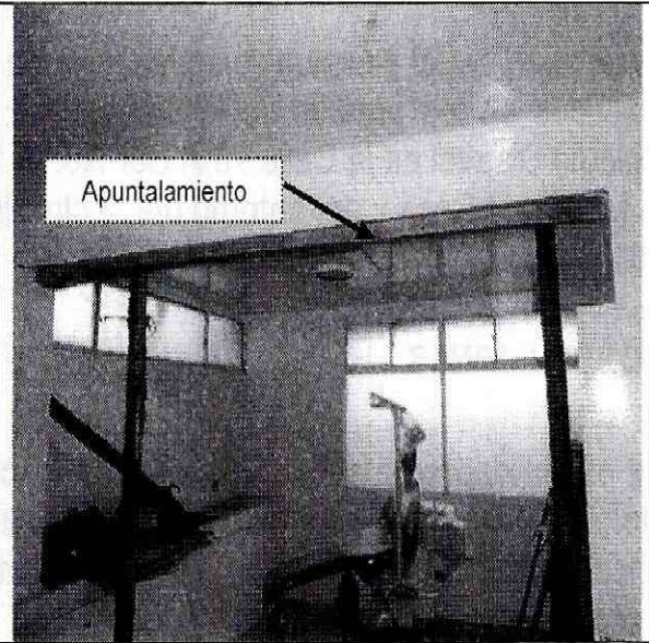
Fotografía 6. Vista de espacio interior del centro de salud, donde se observa apuntalamiento.
