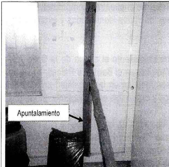
Fotografía 7. Vista de espacio interior del centro de salud, donde se observa apuntalamiento.
