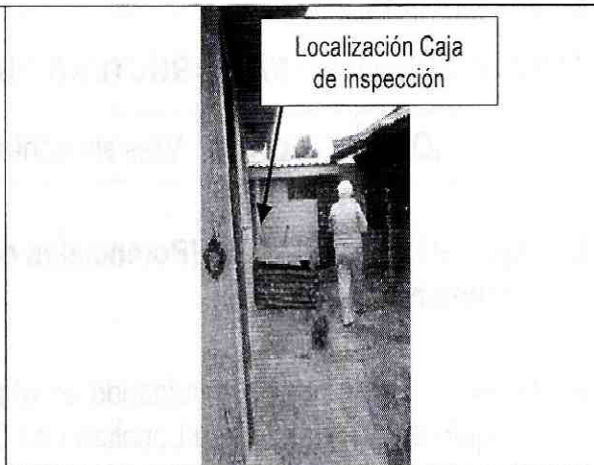
Fotografía 2. Vista de la zona de patio, donde se localiza caja de inspección a donde según la peticionaria confluyen las aguas de escorrentía, cuando ingresan a la vivienda.
