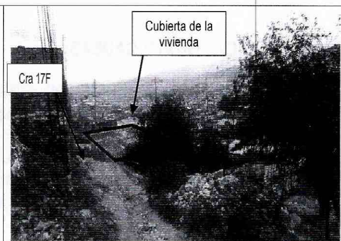
Fotografía 4. Predio evaluado, la cubierta a nivel de la rasante de la vía Cra 17F.
