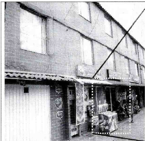
Fotografía 3. Vista de las edificaciones ubicadas en el costado occidental de la Carrera 98 B frente al predio de la Carrera 98 B No. 69 – 49 Sur.
