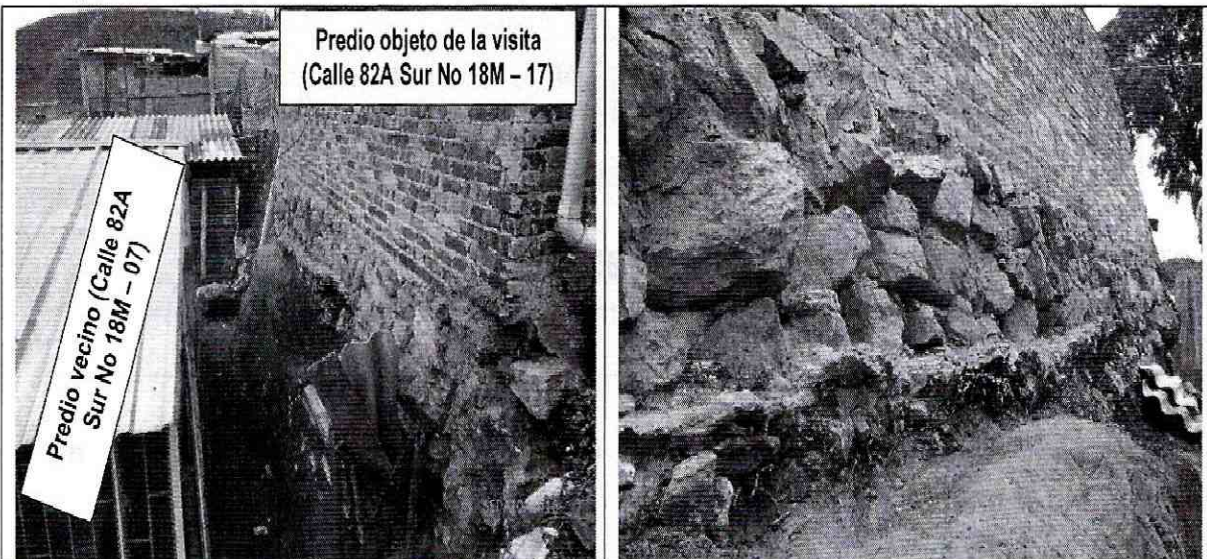
Fotografías 7 y 8. Aspecto general de la cimentación de la vivienda localizada en la Calle 82A Sur No 18M – 17 en el sector adyacente al predio vecino.
