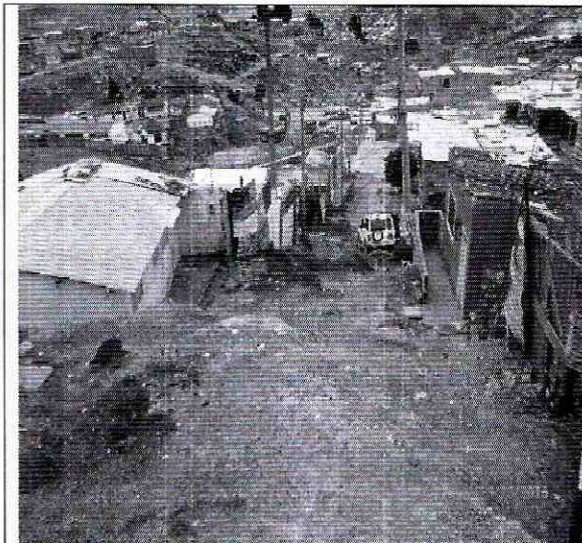
Fotografía 1. Condiciones de la vía Calle 82 A Sur.
