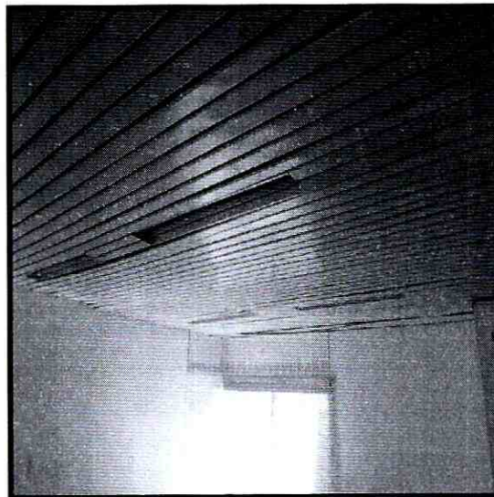
Fotografías 2 y 3. Desplazamiento de la mocheta que conforma la entrada y pandeo de las láminas del cielorraso
