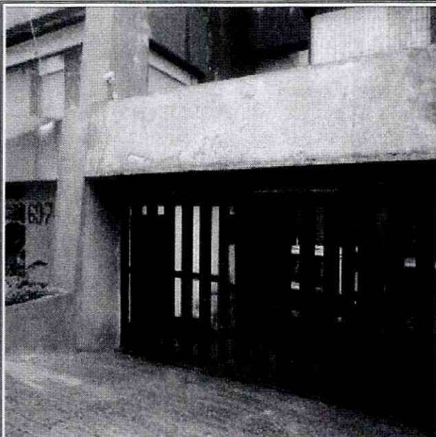
Foto No. 2. Entrada sótano costado norte de la edificación
