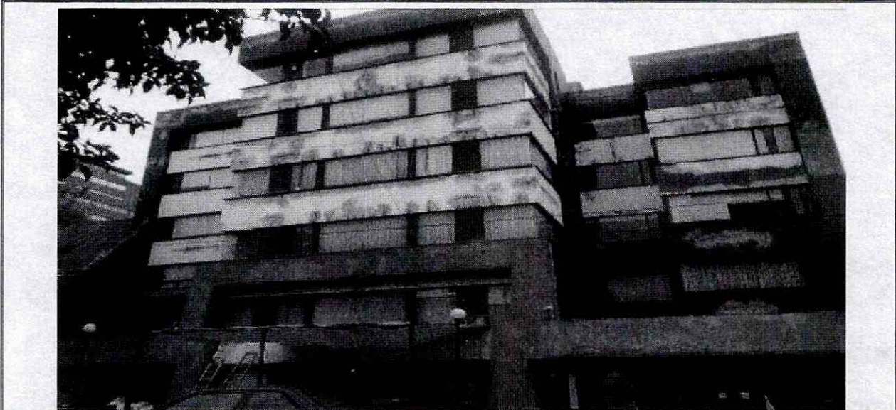
Foto No. 1. Vista frontal de la edificación en el predio de la Carrera 7 A No. 64 – 79, Sector Catastral Quinta Camacho de la Localidad de Chapinero
