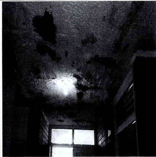
Foto No. 4 y 5. Desprendimientos capa de recubrimiento estructura de cubierta y presencia de eflorescencias
