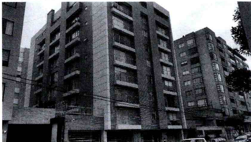
Fotografía 1. Vista general del inmueble ubicado en la Calle 146 # 15 - 63
