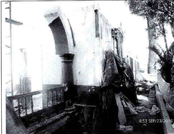
Fotografía 3. Vista del costado oriental de las obras que se adelantan en la "Casona". Se observa cerramiento y actividades normales de obra.
