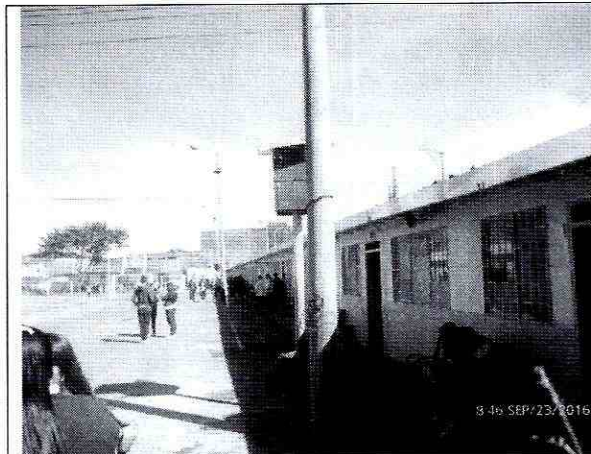
Fotografía 5. Vista de las edificaciones ubicadas en el costado noroccidental del predio. Se observa un buen estado de conservación.
