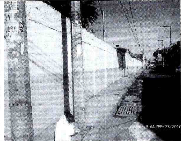
Fotografía 6. Vista panorámica del costado oriental del predio. Donde se observa un buen estado de conservación del muro perimetral.
