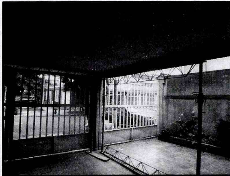
Fotografía 3. Apuntalamiento de la placa de entrepiso del predio de la Calle 85 A No 27-02
