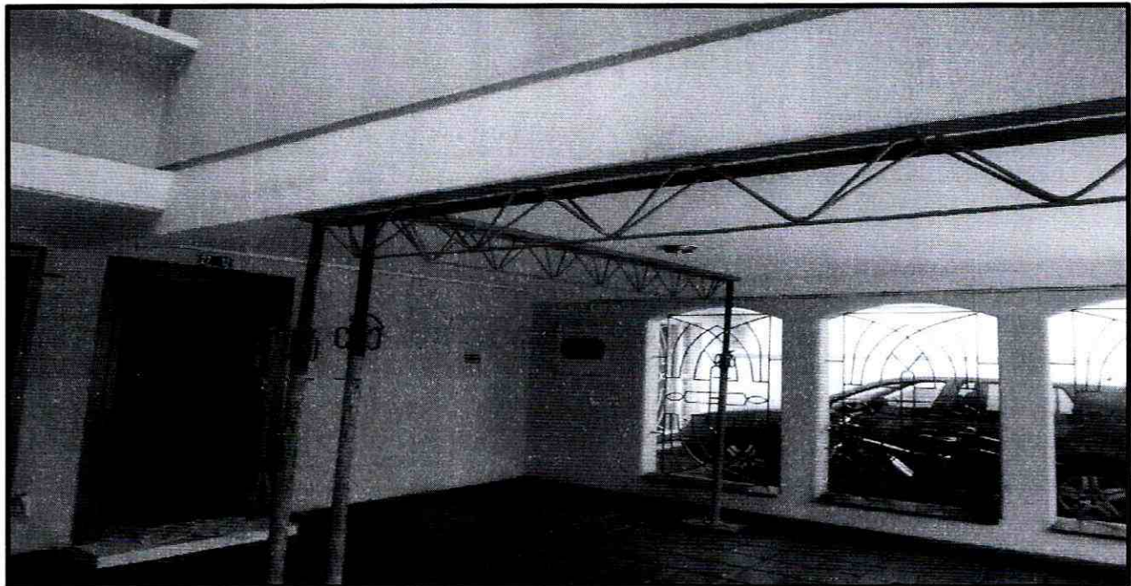
Fotografía 6. Apuntalamiento de la placa de entepiso del predio de la Calle 85 A No 27-12.
