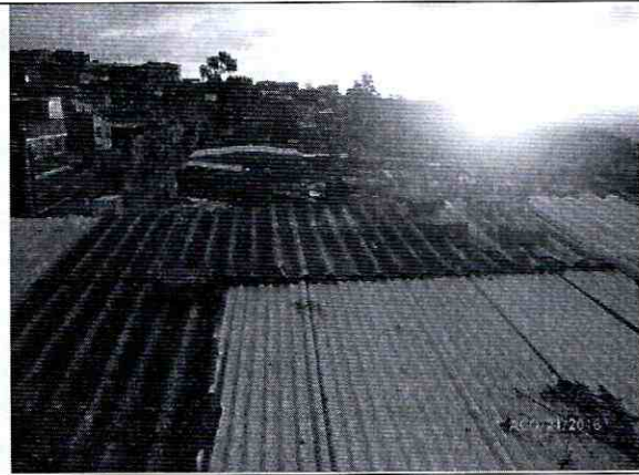
Fotografías 6. Se observa la colocación de nuevas tejas en el área afectada.
