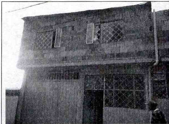
Fotografía 1. Fachada frontal de la vivienda de la Calle 29 Sur No 10 - 50 Este.
