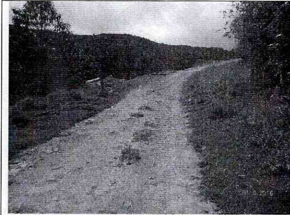
Fotografía 1. Condiciones de la vía de acceso al predio.
