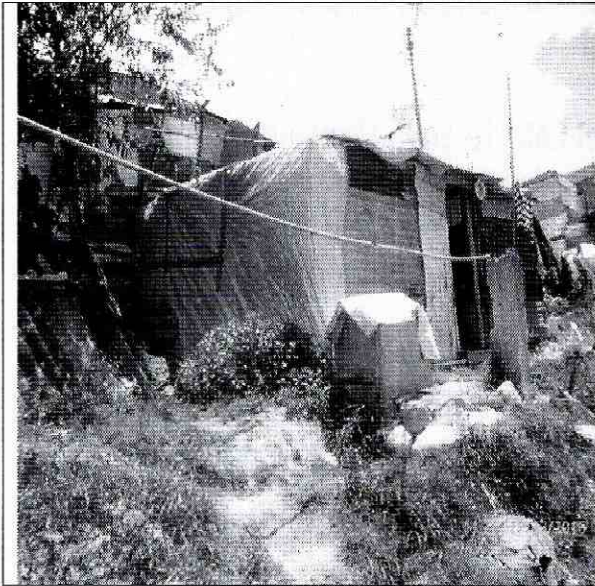
Fotografía 1. Vista panorámica del costado sur occidental de la edificación de la Manzana 78 Lote 18.
