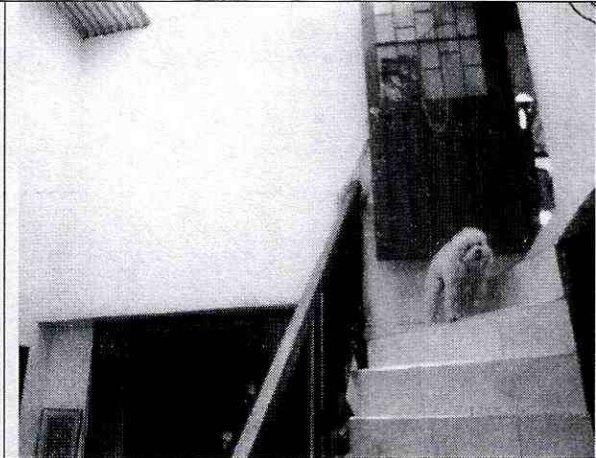
Fotografía 4. Vista del interior de escalera que conduce al tercer nivel de la edificación de la Calle 68 D Sur No. 20 D -16. Donde se observa un buen estado de conservación.
