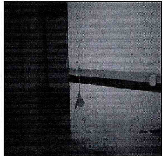
Fotografías 3 y 4. Desprendimientos del pañete en los muros de mampostería del sótano del Conjunto Residencial Parque Central Pontevedra Etapa 3
