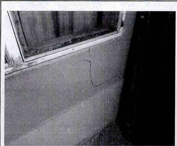
Fotografía 7 y 8. Presencia de fisuras y grietas en muros de la vivienda de la Carrera 77A No. 68A – 12.
