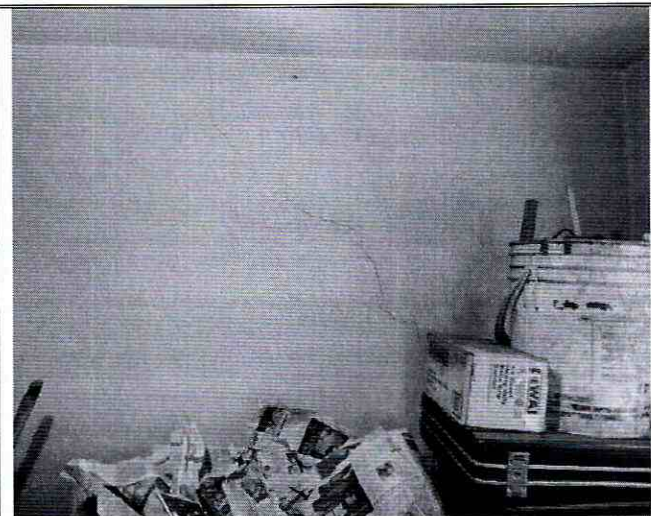
Fotografía 3 y 4. Presencia de fisuras y grietas en muros de la vivienda de la Carrera 77A No. 68A – 12.
