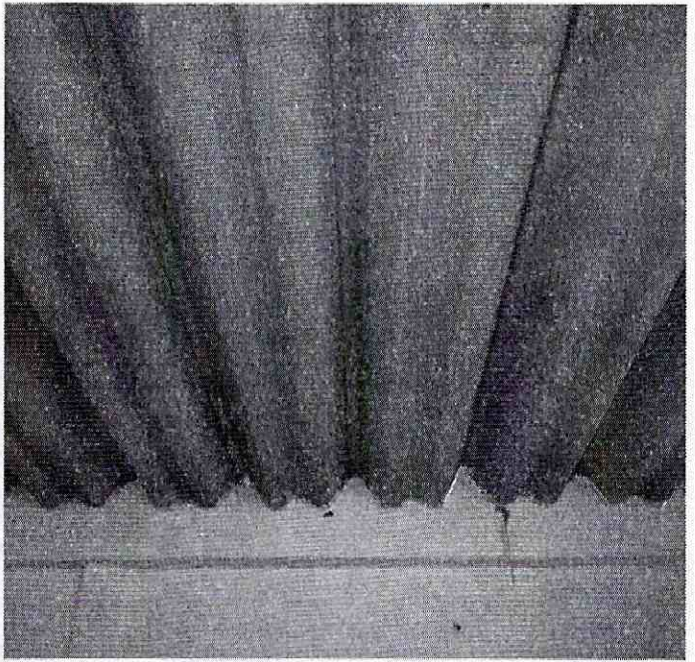
Fotografía 7 y 8. Vista al interior del Salón Comunal
