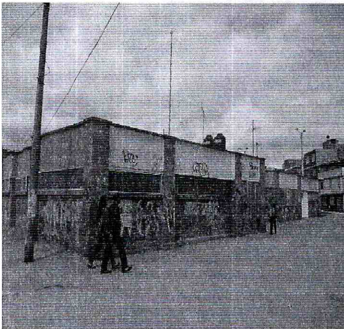
Fotografía 11. Vista del Centro de Salud
