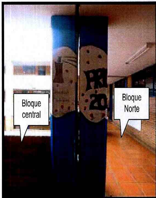
Fotografías 5 y 6. Separación entre parejas de columnas de los bloques central y norte del colegio Los Pinos, localizado en el predio de la Diagonal 4A No 5B-93 en barrio los Laches de la localidad de Santa Fe.
