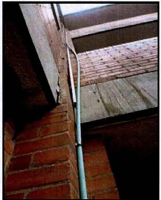
Fotografías 11 y 12. Grietas y desprendimientos de los mampuestos en la mocheta y en enchape en mampostería, en la esquina sur occidental del patio central
