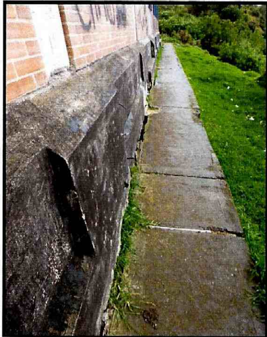
Fotografías 13 y 14. Separación entre el andén y el muro de cerramiento del costado norte, en el colegio Los Pinos, localizado en el predio de la Diagonal 4A No 5B-93 en barrio los Laches de la localidad de Santa Fe.
