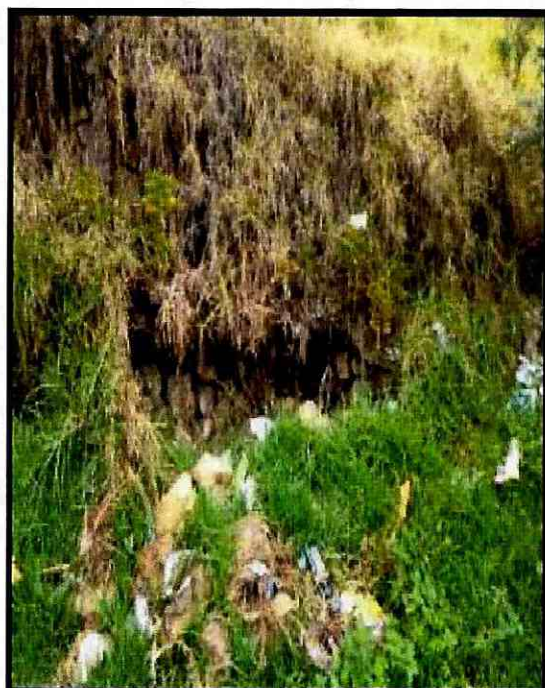
Fotografías 2 y 3. Bloques de piedra rajón sobre la capa vegetal, pertenecientes al antiguo muro en gaviones, localizado junto a la Diagonal 4A.
