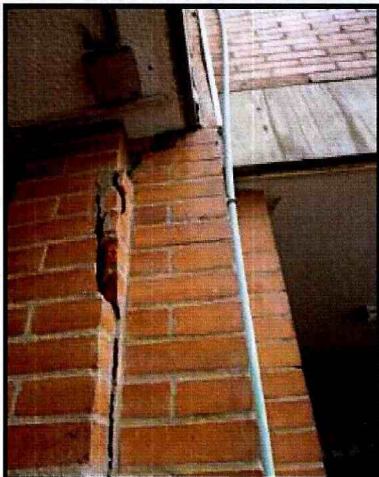
Fotografías 11 y 12. Grietas y desprendimientos de los mampuestos en la mocheta y en enchape en mampostería, en la esquina sur occidental del patio central
