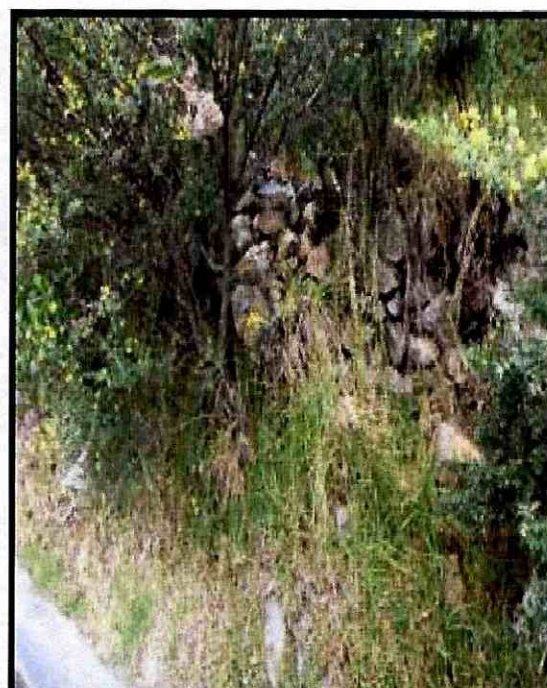
Fotografías 2 y 3. Bloques de piedra rajón sobre la capa vegetal, pertenecientes al antiguo muro en gaviones, localizado junto a la Diagonal 4A.
