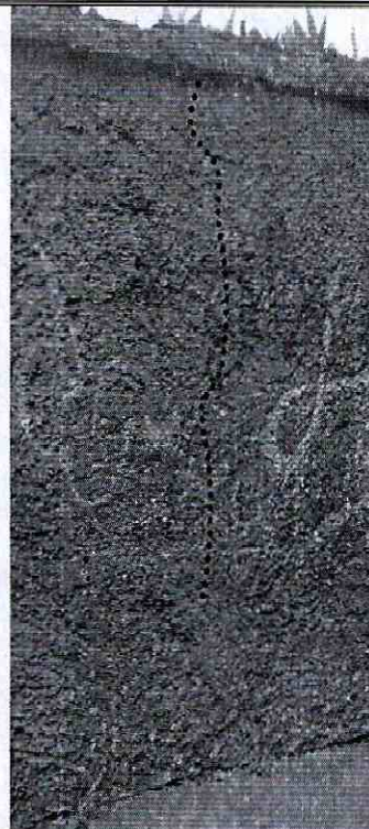
Fotografía 6. Presencia de fisuras en el muro evaluado
