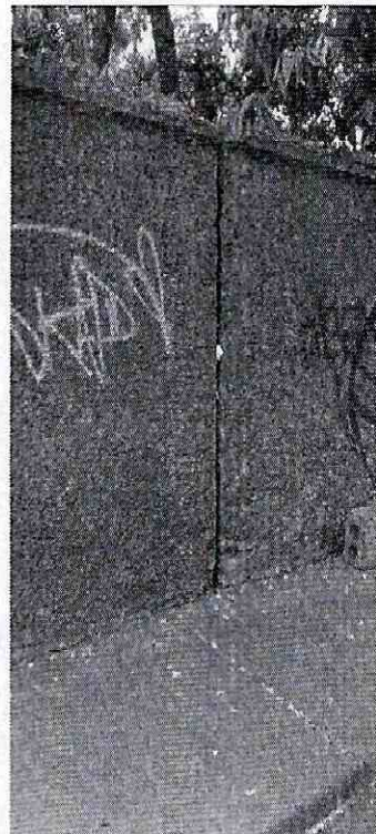
Fotografía 10. Presencia de dilatación en el muro evaluado
